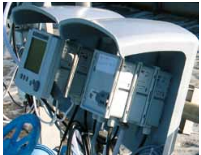
IQ SENSOR NET protegido por un escudo SSH/IQ
