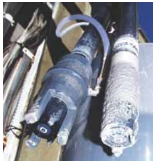
Prueba de la limpieza eficiente con aire comprimido.
